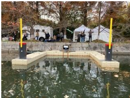
非接触充電機能とロック機構を持たせた栈橋
